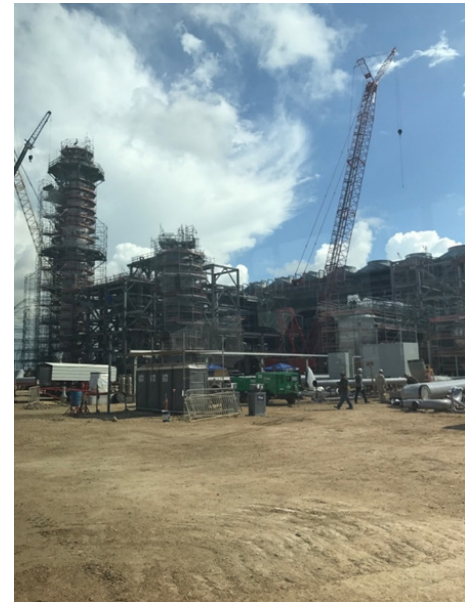
(建設が進むプラント設備①)
