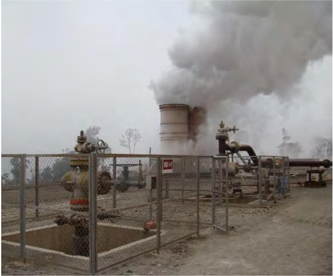
**Gambar 1-6 Pelepasan uap ke atmosfer melalui cerobong AFT**
