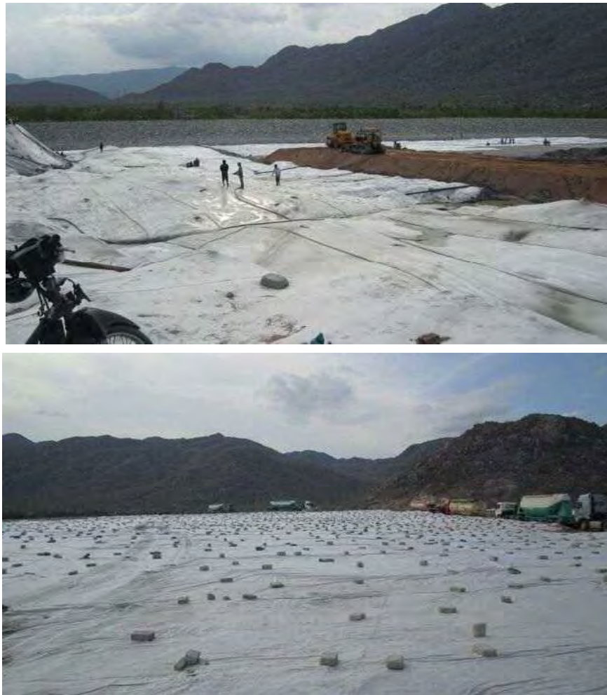
Hình 4.14. Tưới nước và phủ bạt bề mặt bãi xỉ tại bãi xỉ Hố Dừa
