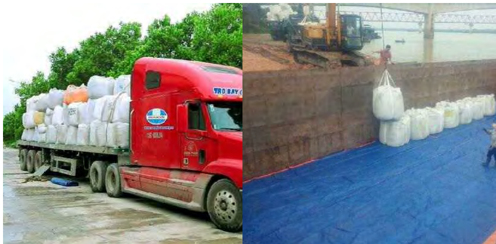
Hình 4.24. Công tác vận chuyển tro bay lên tàu
