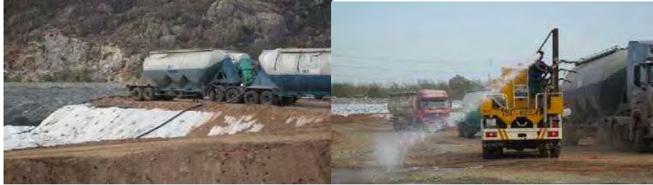
Hình 4.10. Xe chuyên dụng vận chuyển tro xỉ và tưới nước đường nội bộ bãi xỉ
