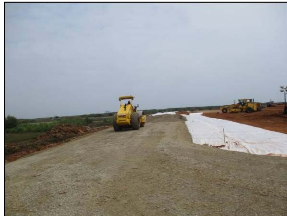
Gambar12. Proses pengerasan akses jalan
