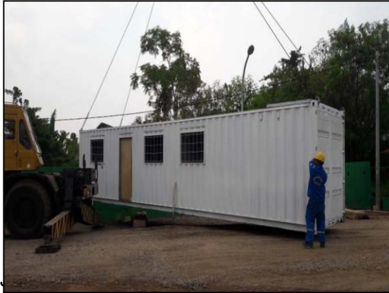
Gambar 7. Penyiapan basecamp pekerja
