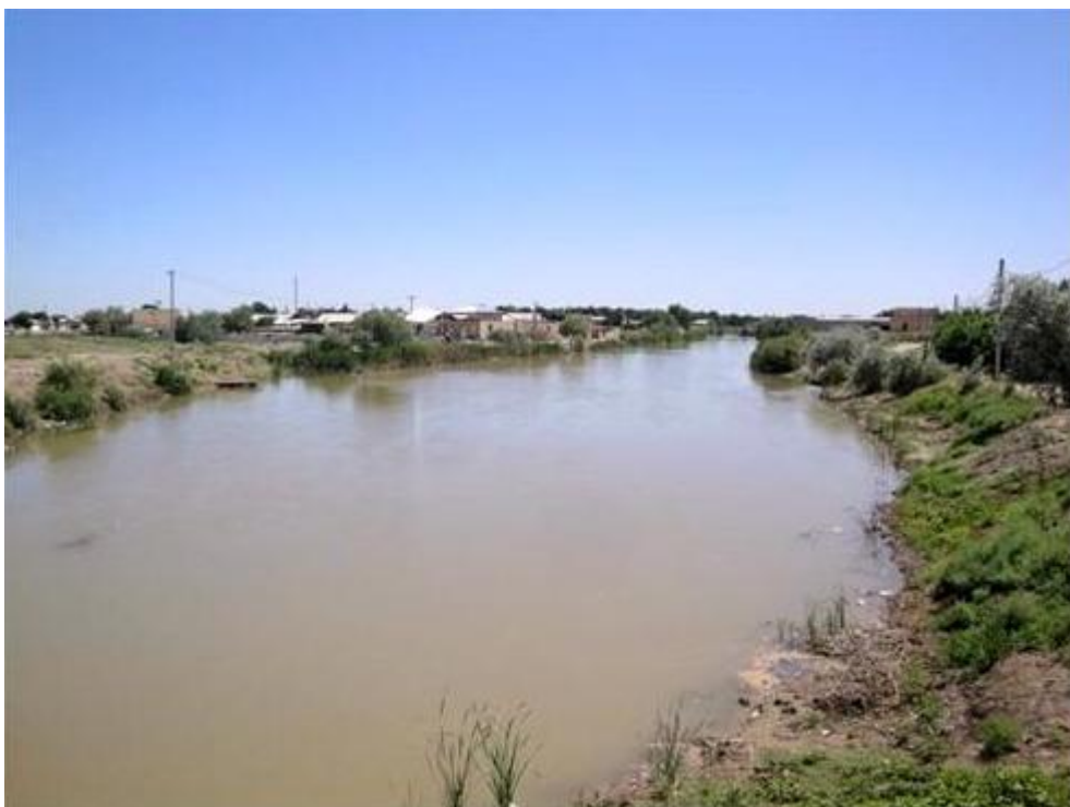
Рис. 5-8: Главный левобережный (ГЛК) коллектор
