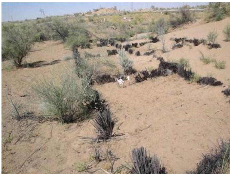
Рис. 7-4: Меры по предотвращению развевания возле обочины дороги М37
