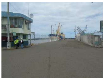
Muelles del Terminal Portuario
