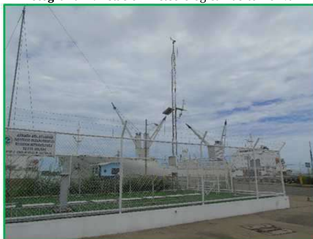
Fotografía 2: Estación Meteorológica Puerto Bolívar
