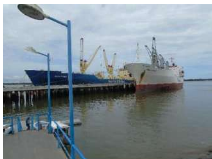
Muelles del Terminal Portuario
