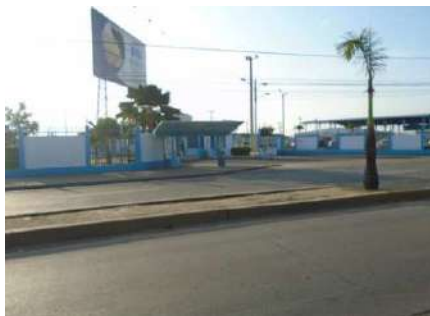
Exteriores del terminal Portuario
