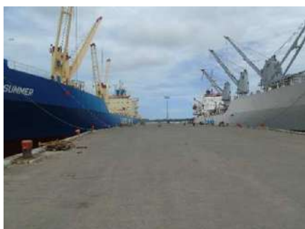
Muelles del Terminal Portuario
