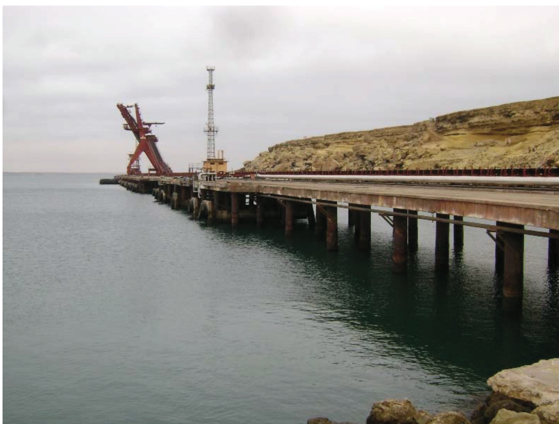
Fotografia 3.8 – Ponte-cais do Porto de Sacomar, que será alvo de reparações estruturais no molhe e nos pilares
