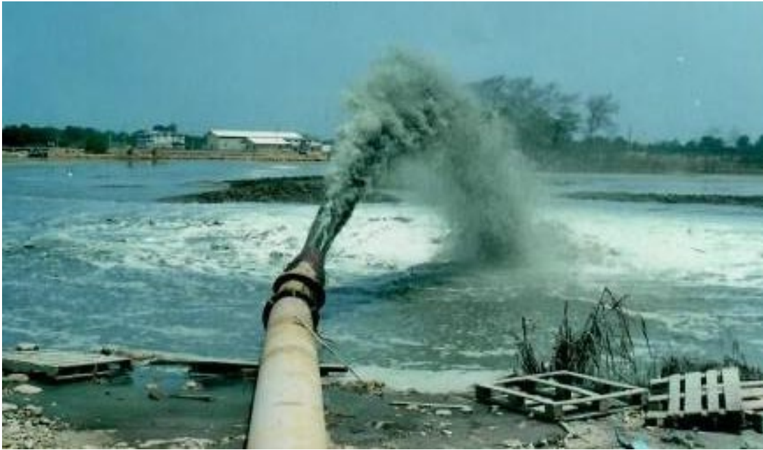
Vertido de sedimentos dragados de los muelles en las piscinas de sedimentos, entre los años 2004- 2009
