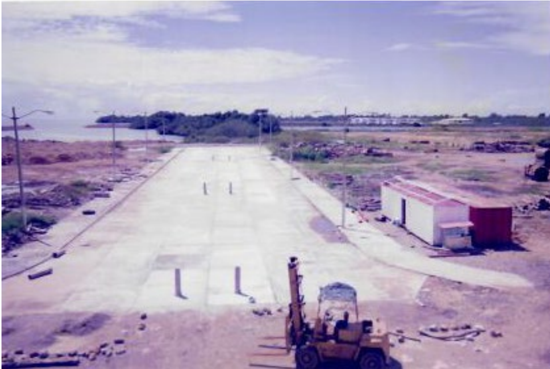
Construcción de obra vial Av. 2da Transversal, entre actuales patios No. 5 y No. 8, alrededor del año 2000
