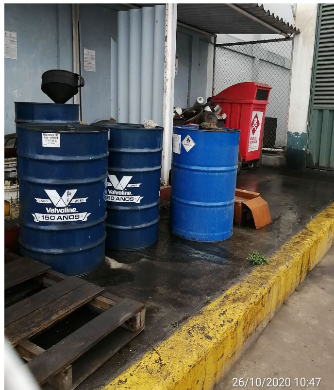
Cubeto de Centro de Acopio de Desechos Peligrosos (Celda 1)
