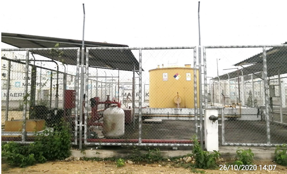
Zona de combustibles, construida en el año 2012
