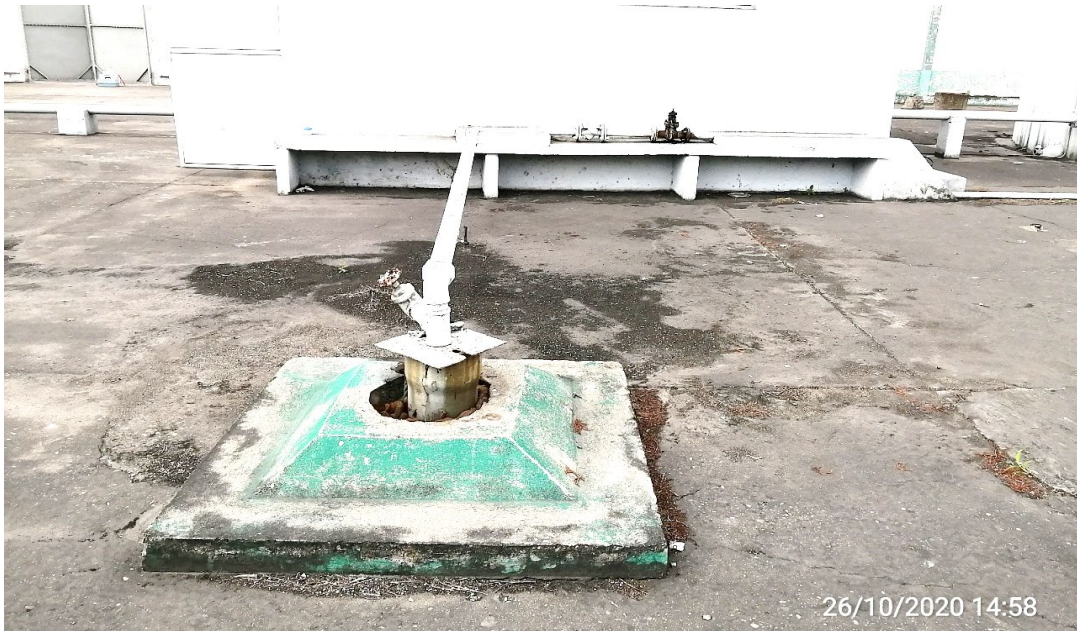
Pozo No. 2, construida en el año 2012
