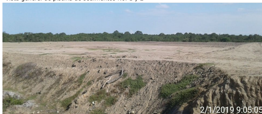
Vista general de piscina de sedimentos No. 3
