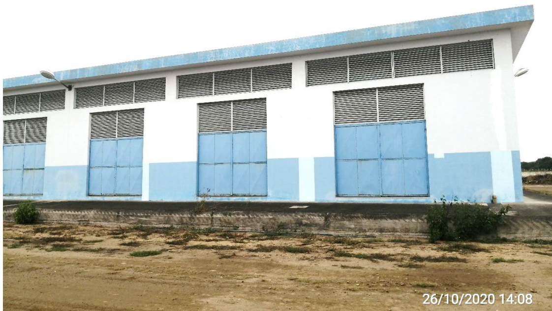
Sala de generadores de emergencia, construida en el año 2012
