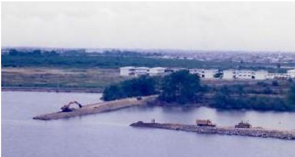
Trabajos para la consolidación del área del actual Patio No. 10, año 2012.
