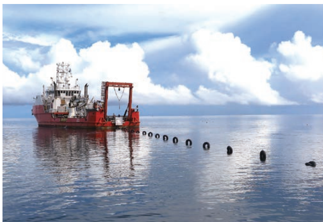
写真提供：日本電気株式会社
