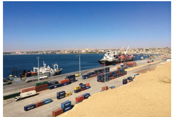
(写真提供：豊田通商株式会社(開発予定地))
