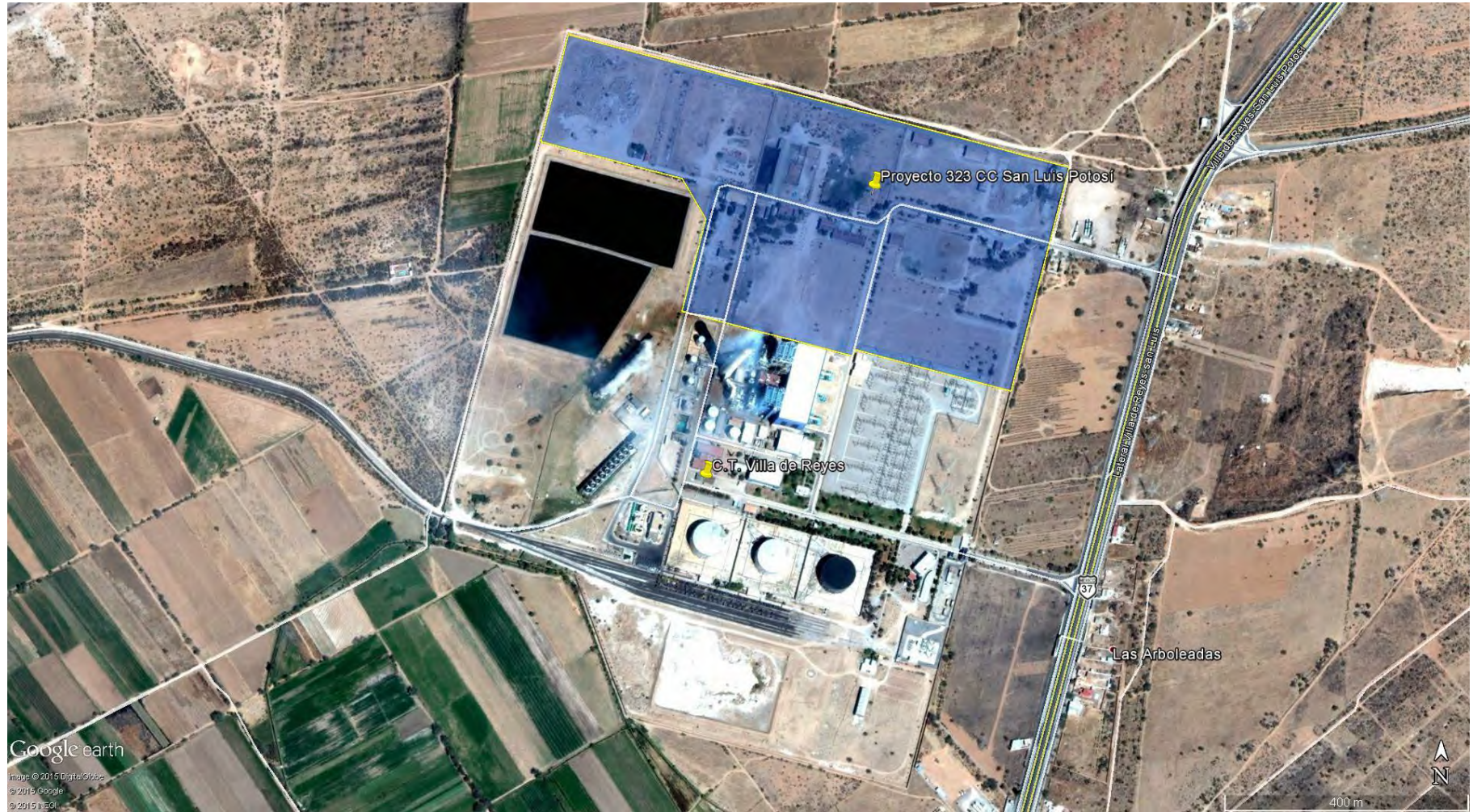
Figura 1-3: Ubicación del predio del Proyecto 323 CC San Luis Potosí, dentro de la C.T. Villa de Reyes (fotografía aérea de Google Earth)
