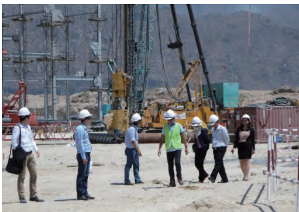
建設工事に関する現地調査の様子
