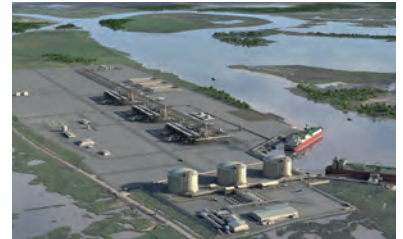
Photograph courtesy of Cameron LNG LLC
