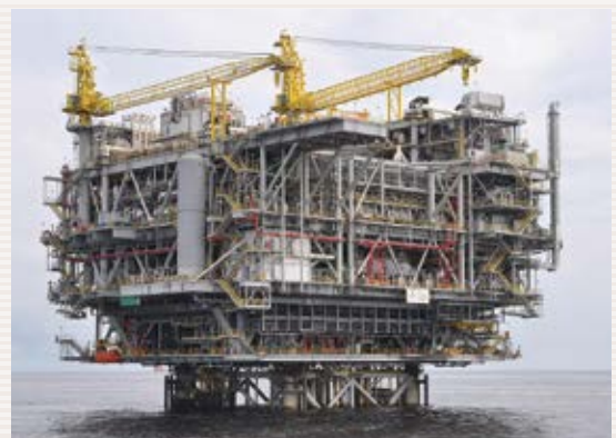
写真提供：国際石油開発帝石株式会社
